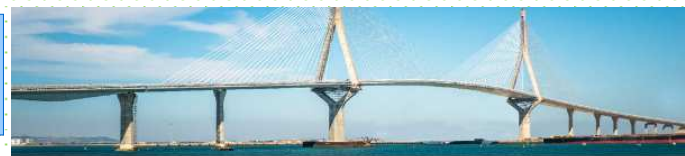
Cádiz, Puente de la Constitución de 1812
